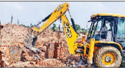
सोनीपत। जेसीबी के जरिये अवैध निर्माण गिराते हुए।
